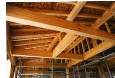
エリコの架構。桁梁と小屋梁は、150mm角材を2段重ねにした重ね梁とし、鉛直荷重を支えている。また、6mを超える梁には、集成材を使用している
