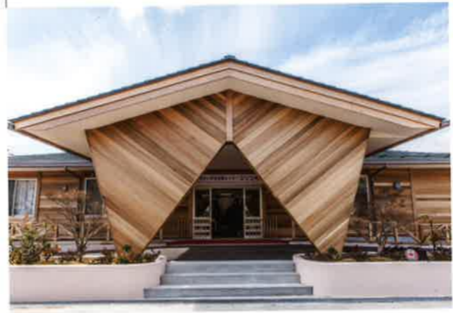
カナダ産材のみでつくる建物は、日本でも始めて。150mm角のカナダツガ構造材があったからこそ実現したプロジェクトといえる
