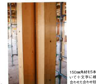
150mm角材を5本用いて十字に組み合わせた合わせ柱
