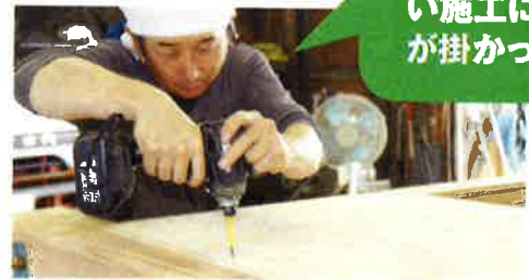
試験体は笹森工務店(埼玉県富士見市)の笹森建夫さん(写真)が製作した。笹森さんは「スギに打ったクギは時間がたつと抜けやすいので、ネジの方がいいかもしれない」と話す
