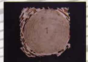
保存処理していないヒノキ心材の状況に比べ、辺材にシロアリの被害を多く受けている違いが見られます
