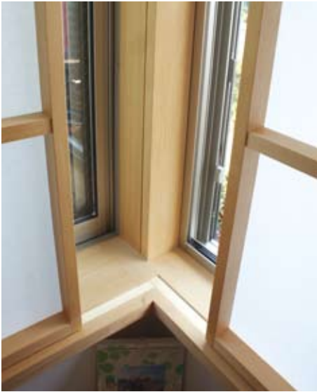
窓枠と一体化した収納デザイン (左) 構造材には樹齢60年の紀州 産スギ・ヒノキ。桁には目透かし を入れてきれいに納める (下)
