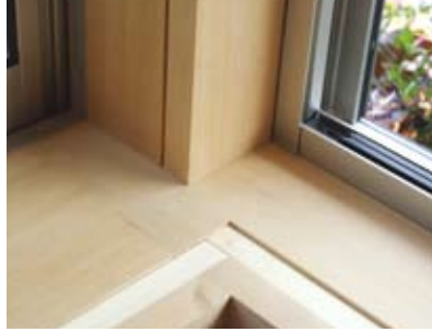
2階の地震の揺れに強い枠材の納まり (左・下) 階段は踏み板 35mmのカナダツガ。蹴込みのない ストリップ 踏み板の納まりに注目 (右)
