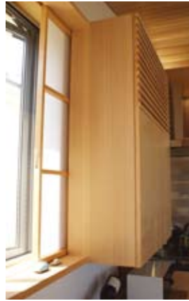
窓枠と一体化した収納デザイン (左) 構造材には樹齢60年の紀州 産スギ・ヒノキ。桁には目透かし を入れてきれいに納める (下)
